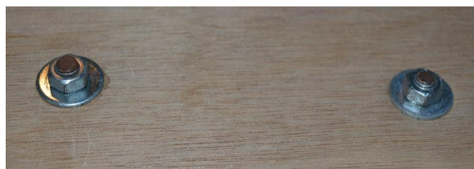
Εικόνα 13: Γυρίστε την ξύλινη βάση ανάποδα και στερεώστε τις ντίζες χρησιμοποιώντας παξιμάδια και ροδέλες
