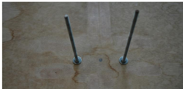
Εικόνα 12: Στερεώστε τις σπειροειδείς ράβδους χρησιμοποιώντας παξιμάδια και ροδέλες
