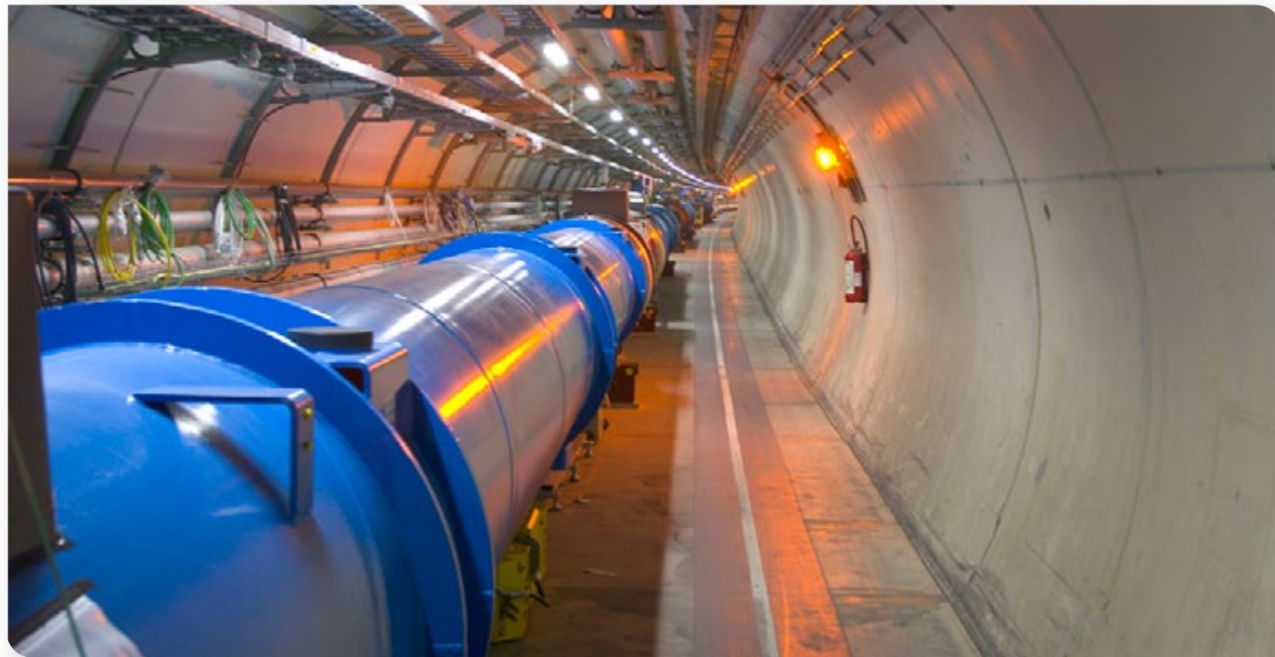
Οι μαγνήτες του Μεγάλου Αδρονικού Επιταχυντή LHC στο CERN κατά την εγκατάστασή τους (φωτογρ. ATLAS Experiment © 2014 CERN).
